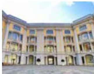
Ansbach, Residenz Innenhof
